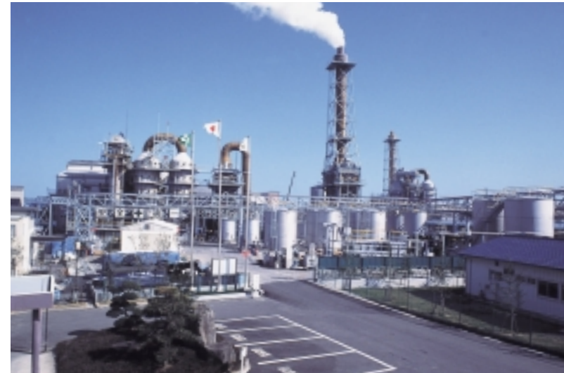
産業廃棄物焼却施設(呉羽環境株式会社)
