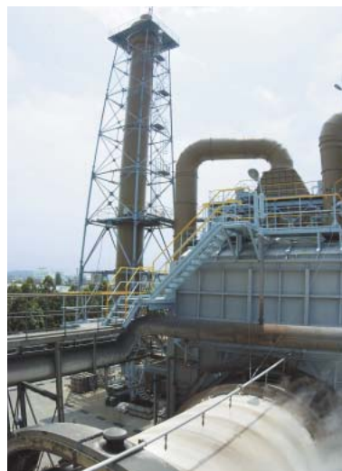
産業廃棄物焼却施設 (呉羽環境株式会社)
