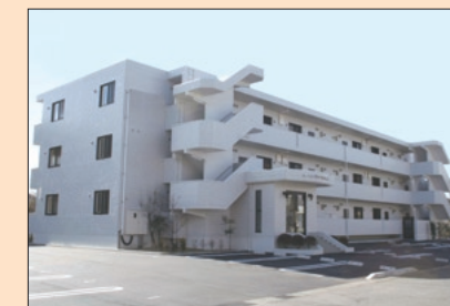
クレハ錦建設株施工賃貸マンション
