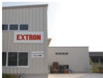
クレハエクストロン(株) 新工場外観
