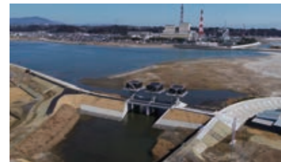
中田川水門全景(いわき市)
