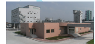
呉羽(常熟)フッ素材料有限公司 工場
