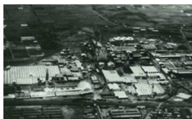
呉羽化学工業設立当時の錦工場(現いわき事業所)
