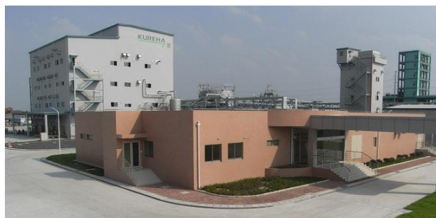
(写真：工場外観)
