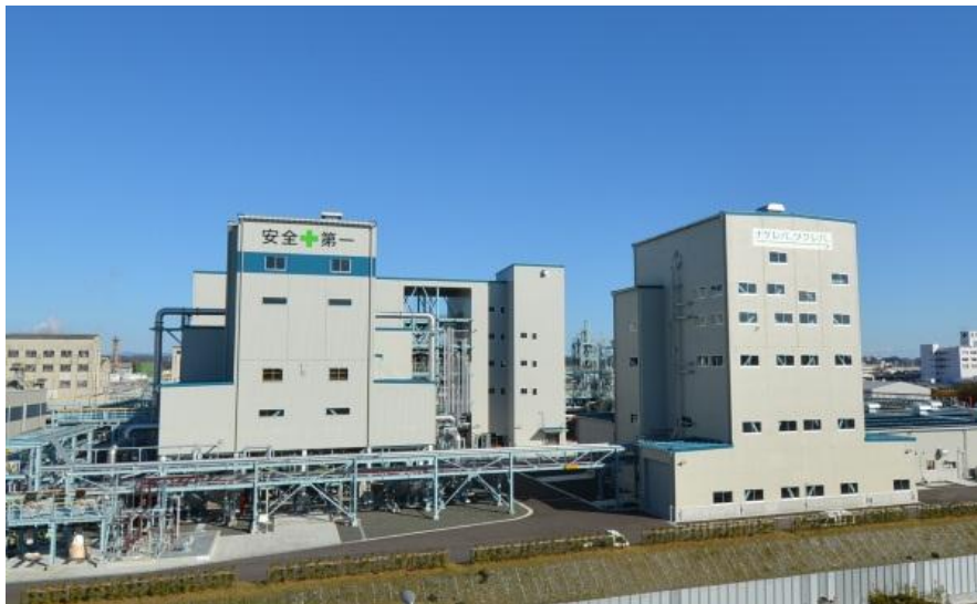
<増強設備外観>
