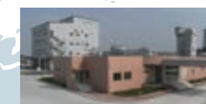
呉羽(常熟)フッ素材料有限公司 工場
