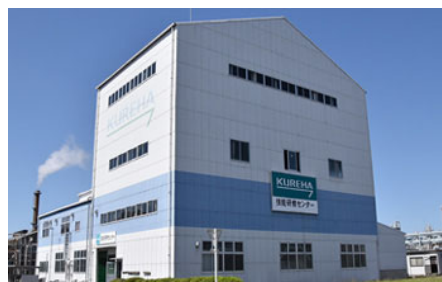
技能研修センター
